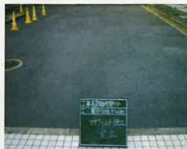
マサコートロード施工後
